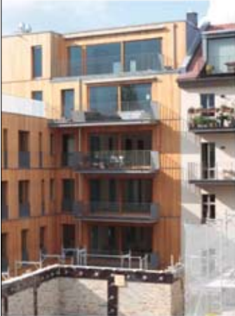
► Die hoftseitige Fassade aus Lärchenholz gliedern horizontal verlaufende Aluminiumbleche, die einen geschossweisen Brandüberschlag verhindern
